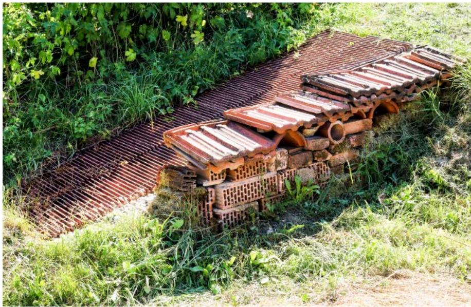
**Oben: Die „Resterampe“ aus aufgestellten alten Dachziegeln überbrückt schubkarrengerecht und rutschsicher Höhenunterschiede.**
